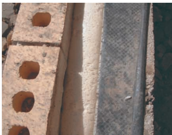
La inyección se realiza con un sistema específico de celda abierta y baja densidad.
