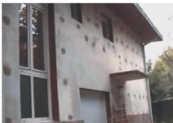
Estado de la vivienda tras mejorar la eficiencia energética, a la espera del acabado final
