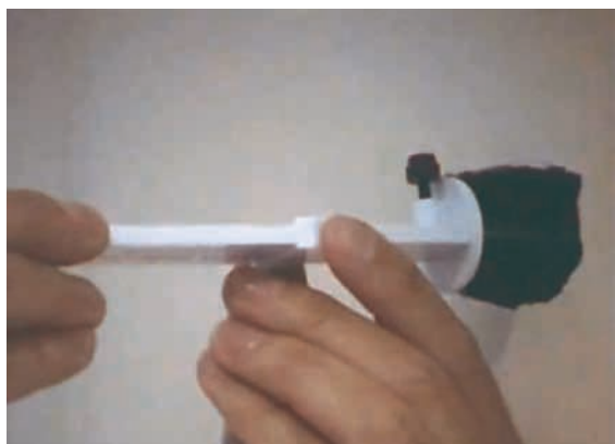
Medida del espesor de la cámara a través de una cata.
