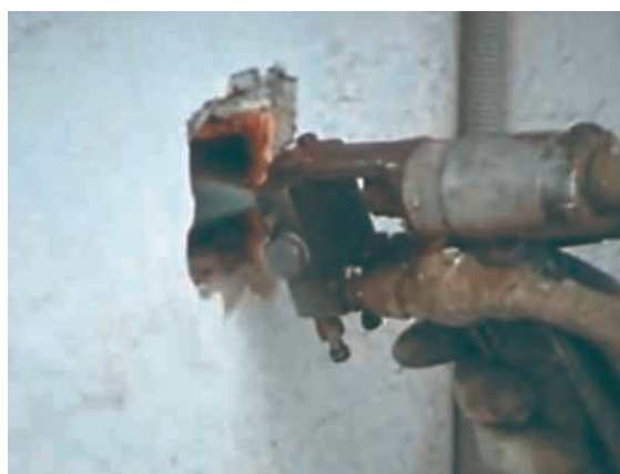
Inyección a través de aberturas mayores.
