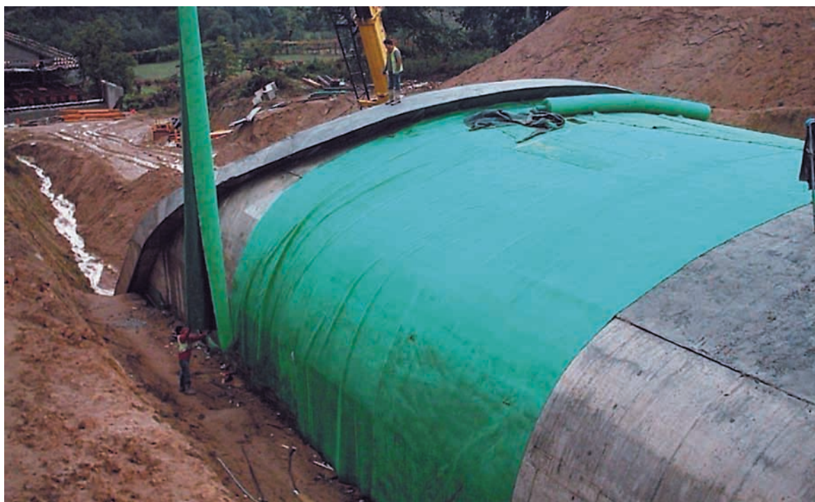
Figura 9. Túnel alternativo Estrada N 1. Ponte de Lima- Viana do Castelo. Portugal. 10.000 m 2 GBR-C. Falso túnel.
