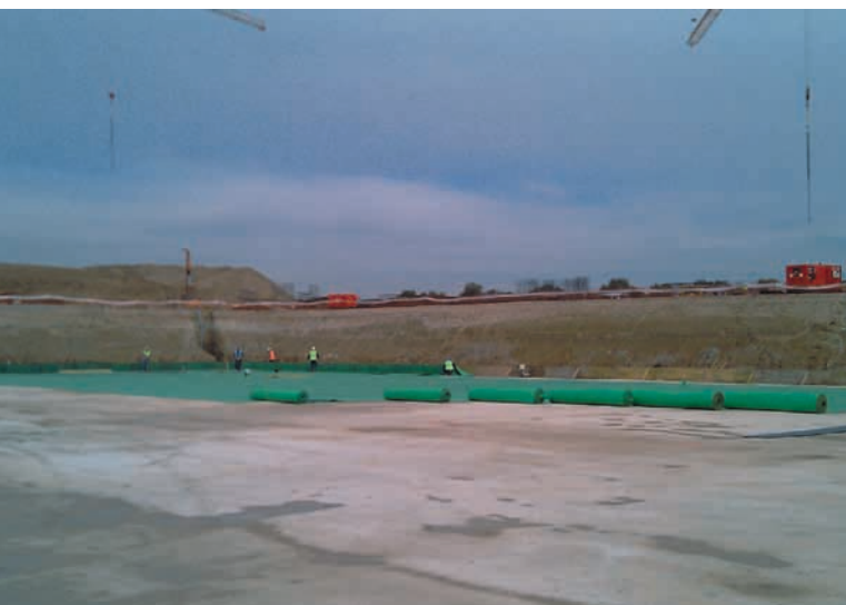
Figura 12. Hospital de Torrejón de Ardoz. Madrid. 20.000 m 2 GBR-C bajo solera de cimentación.
