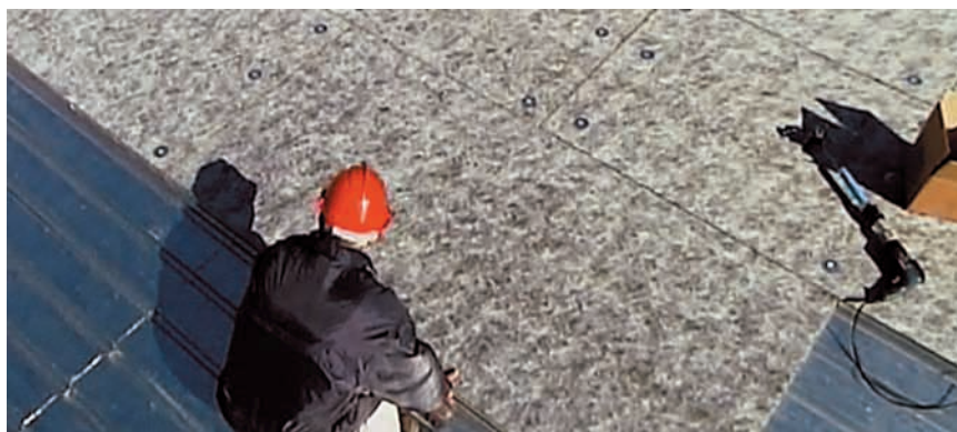
Ejecución de una cubierta con aislamiento térmico PIR con recubrimiento velo vidrio bituminado cara superior.
