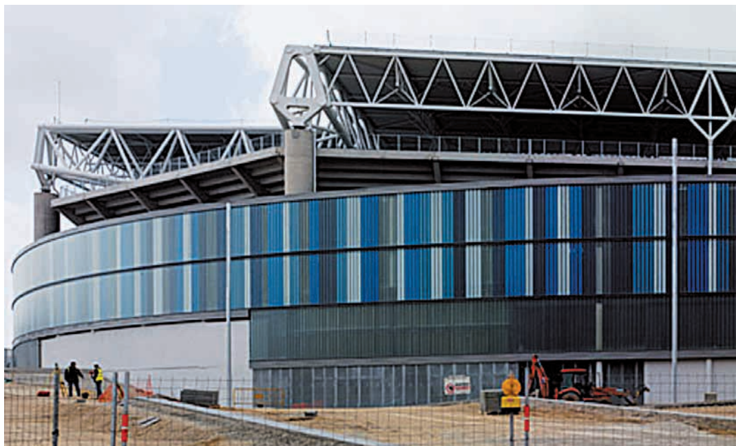
Estadio del R.C.D. Español (Marck Fenwick). Cubierta metálica con aislamiento térmico PIR.
