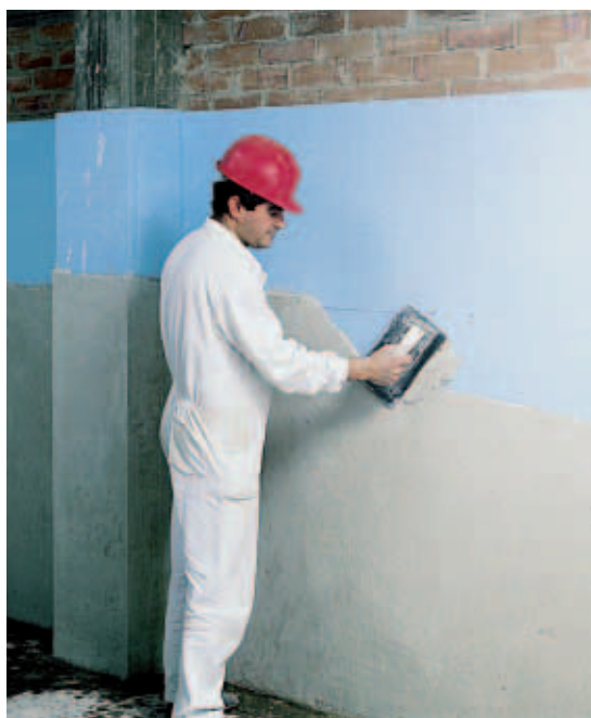
Colocación de Wallmate
