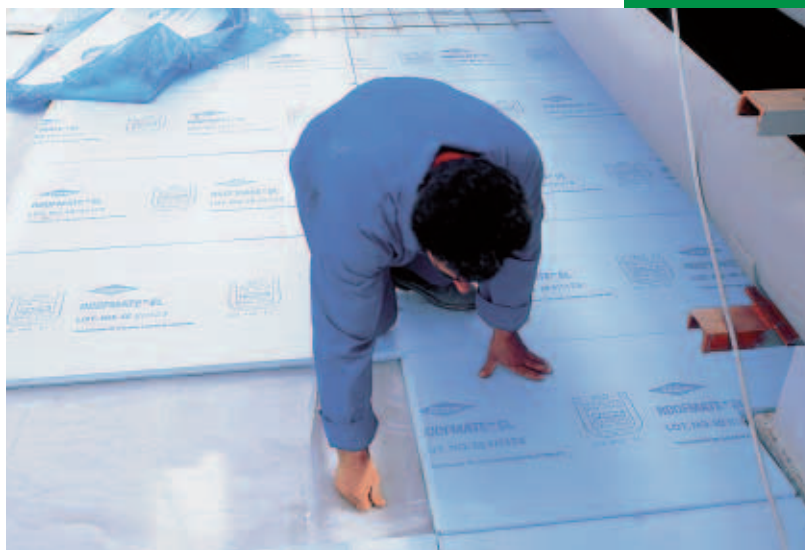
Colocación de Roofmate
